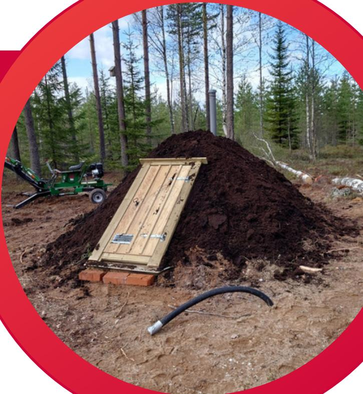
Natürlich kann der Keller auch auf ebener Bodenfläche eingebracht werden, wenn man ihn entsprechend drainiert und den Boden um ca. 0,5-1,0 m unter Geländeniveau absenkt.
